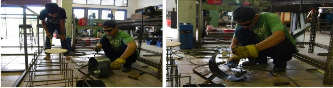
Gambar 2. Proses Pembuatan Kerangka untuk Sirkulasi Udara
