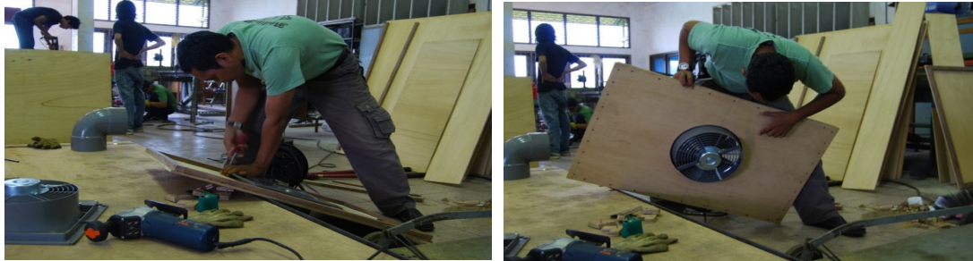
Gambar 3. Proses Pemasangan Exhaust Fan
