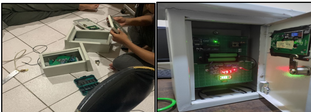
Gambar 4. Pembuatan Dan Instalasi Alat Uji Kualitas Air Portabel
