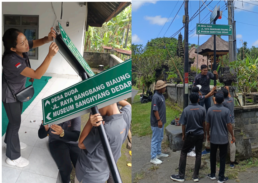
Gambar 5. Pemasangan Sign Penanda Arah
