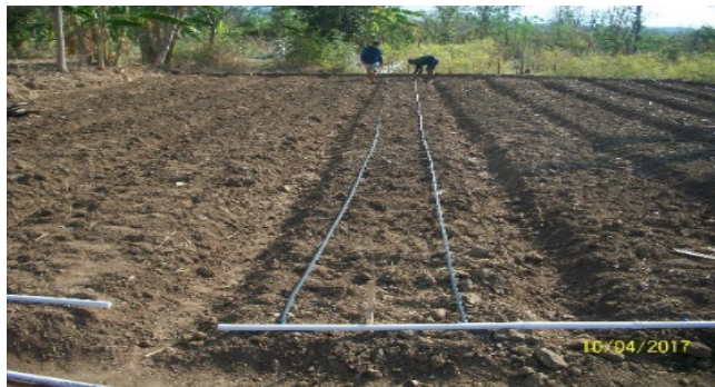
Gambar 7. Peragaan pemasangan jaringan pipa tetes (Negara, 2017)
