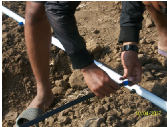
Gambar 6. Peragaan tim pemasangan pipa tetes pada jaringan pipa pvc (Negara et al., 2017)
