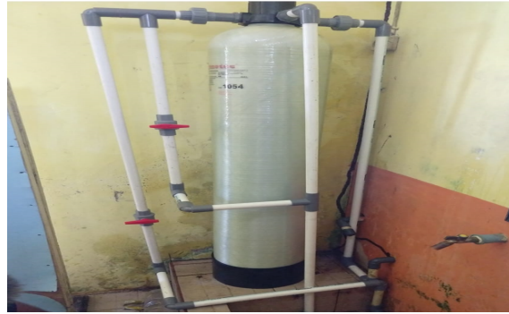
Gambar 3. Tabung Filter FRP Ukuran 1054 Berisi Ferrolite Dan Pasir Silika Untuk Pemyaringan Pertama Sebelum Masuk Ke Tangki/Tandon Air
