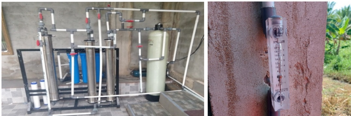
Gambar 2. Instalasi Mesin Air Bersih RO Dan Flowmeter Pengukur Debit Aliran Hasil RO Yang Masuk Ke Tangki Clean Water
