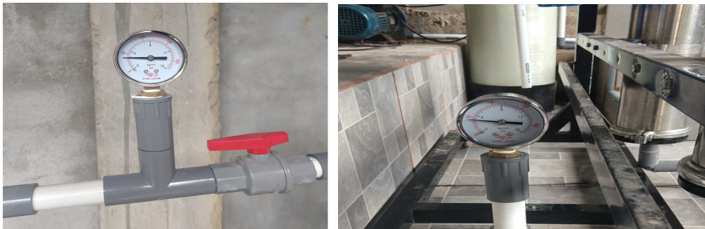
Gambar 4. Manometer Ke-1 Untuk Mengukur Tekanan Air Pada Pipa Setelah Melewati Tabung FRP Dan Manometer Kedua Sebelum Masuk Housing Membran UF Dan RO
