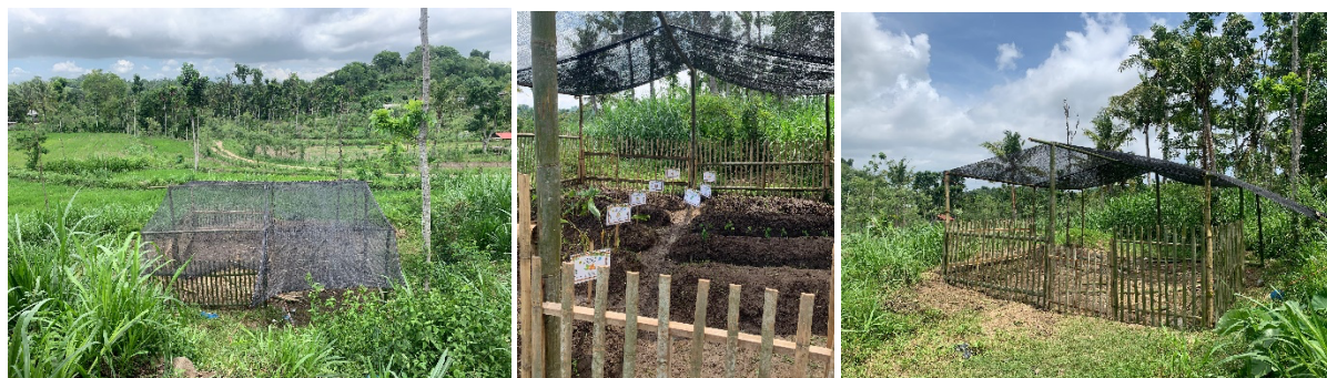
Gambar 1. Konstruksi bangunan green house TOGA
