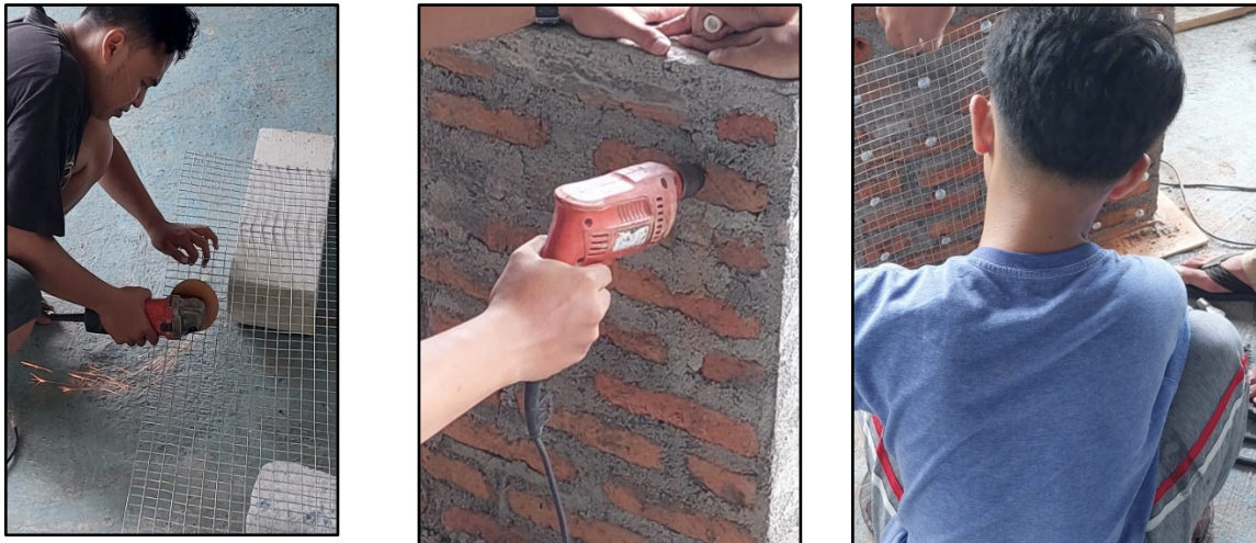
Gambar 7. Simulasi Pembuatan Teknologi Fero semen
