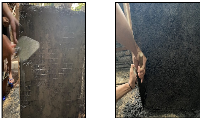
Gambar 8. Dinding Fero semen Yang Telah Diplester
