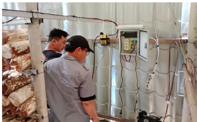
Gambar 4. Fasilitator dan tim pendamping memberikan bimbingan langsung dan dukungan teknis dalam penerapan teknologi pengatur suhu dan kelembaban kumbung berbasis IoT.
