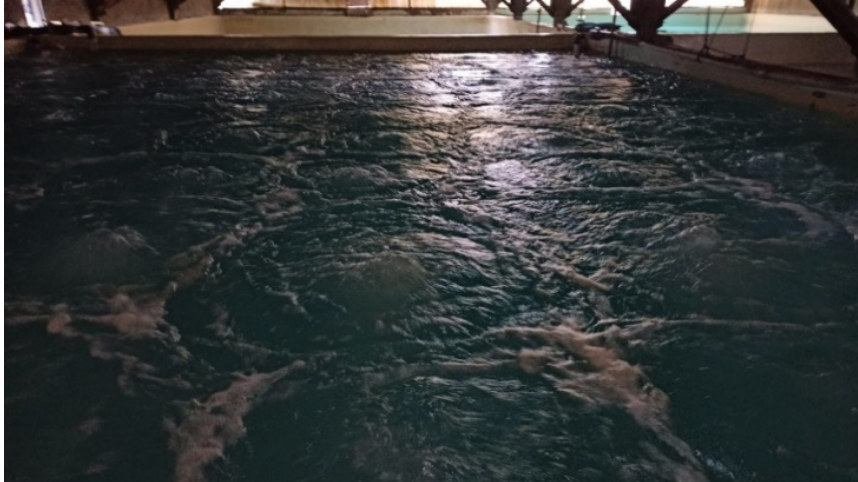
Gambar 3. Reservoir yang diberi kaporit dan diblower
