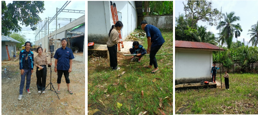
Gambar 7. Pemasangan Antena Penerima
