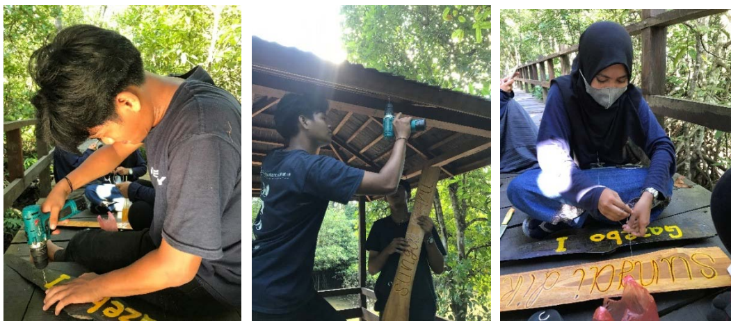
Gambar 3. Proses pemasangan papan nama gazebo
