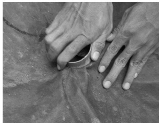
Gambar 6. Pembuatan Saluran Pembuangan : Penekanan Terpal dengan Potongan Pipa
