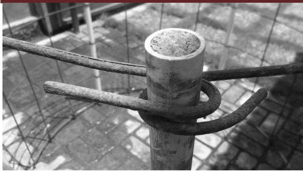
Gambar 2. Ukuran Panjang Besi Dilebihkan untuk Bagian Penyambungan
