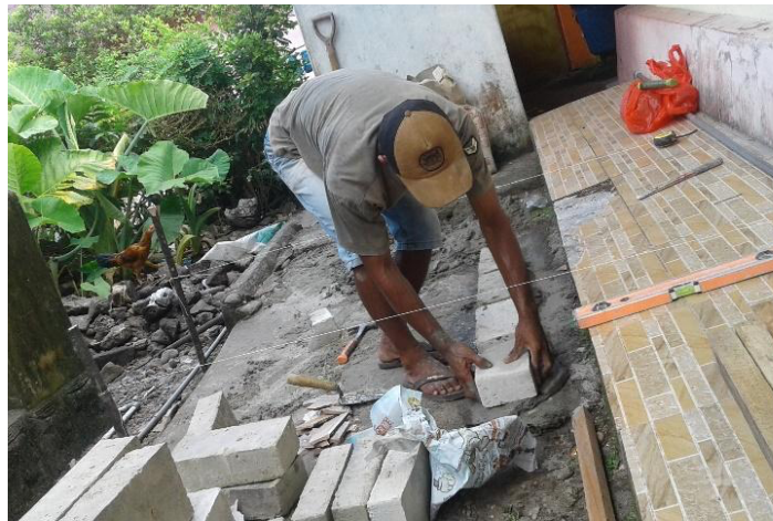
Gambar 2. Pembuatan dasar tempat peletakan akuaponik
