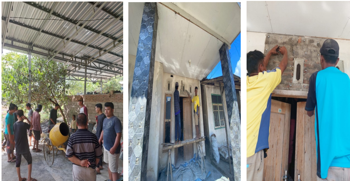
Gambar 4. Proses Membuat Mortar Semen Hidrolis, Pengupasan Dinding Serta Pemasangan Wiremesh
